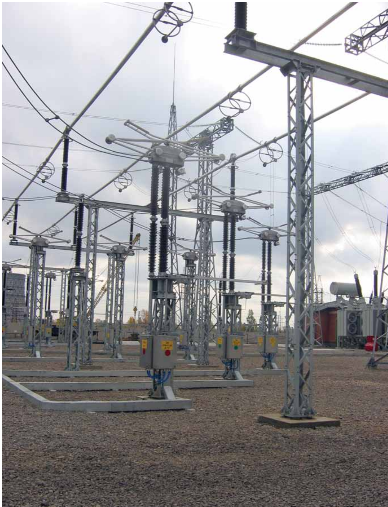
Рис. 7. Подвод кабелей к оборудованию в стальных коробах
