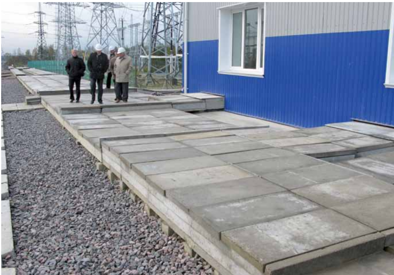
Рис. 4. Ввод кабелей в здание ОПУ выше нулевой отметки
