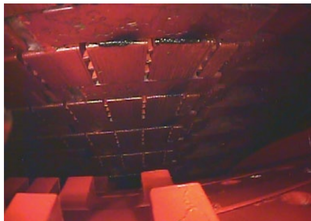
Рисунок 5. Следы загрязнения в зоне стенки паза
