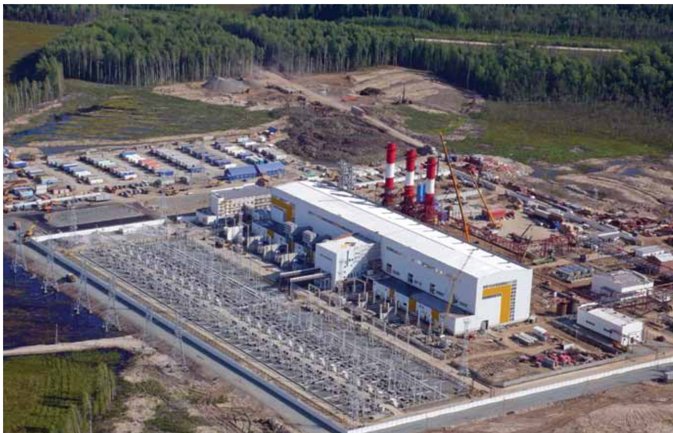
Приобская ГТЭС, ЗАО «Монтажное управление № 3»
