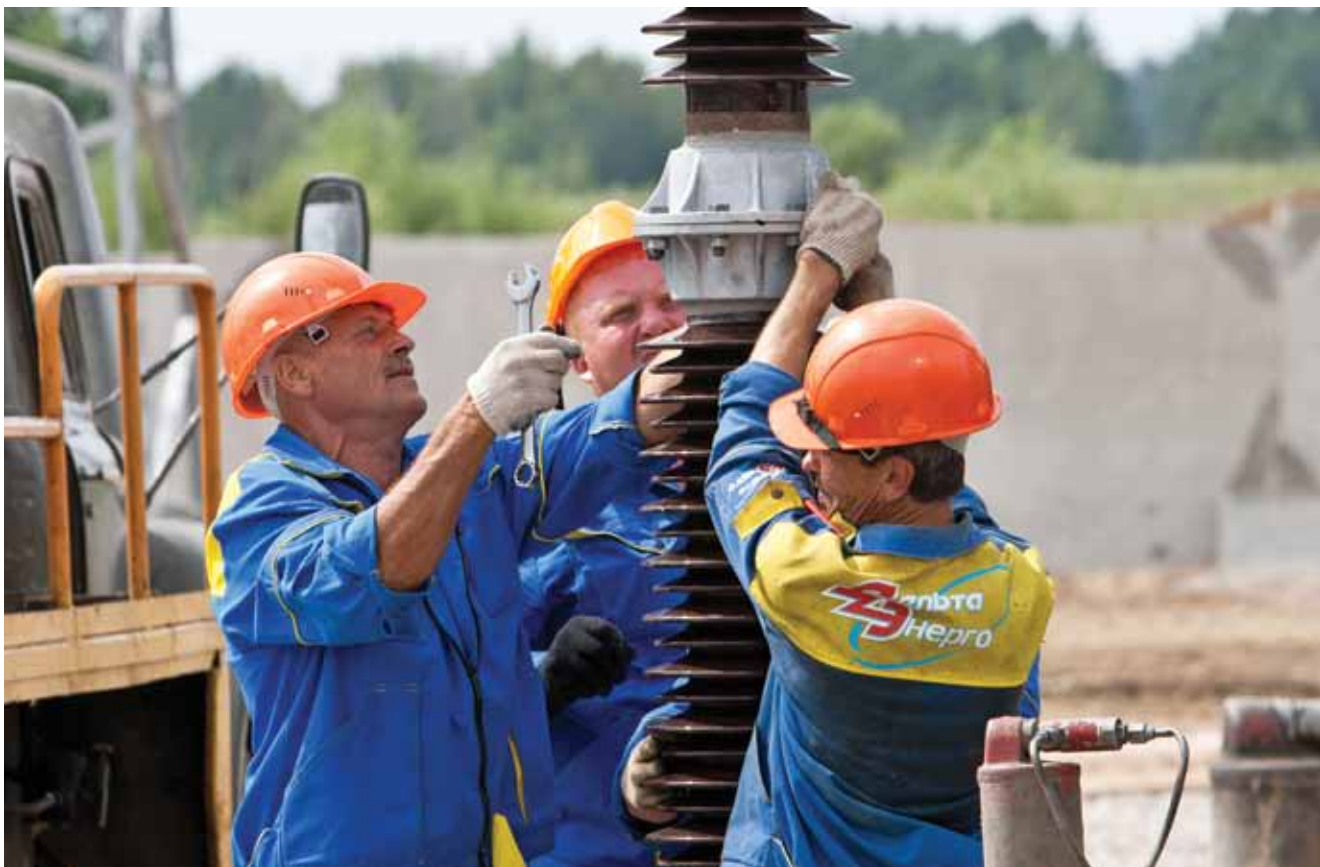
Расширение ПС 500 кВ Амурская. ЗАО «Дельта-Энерго»
